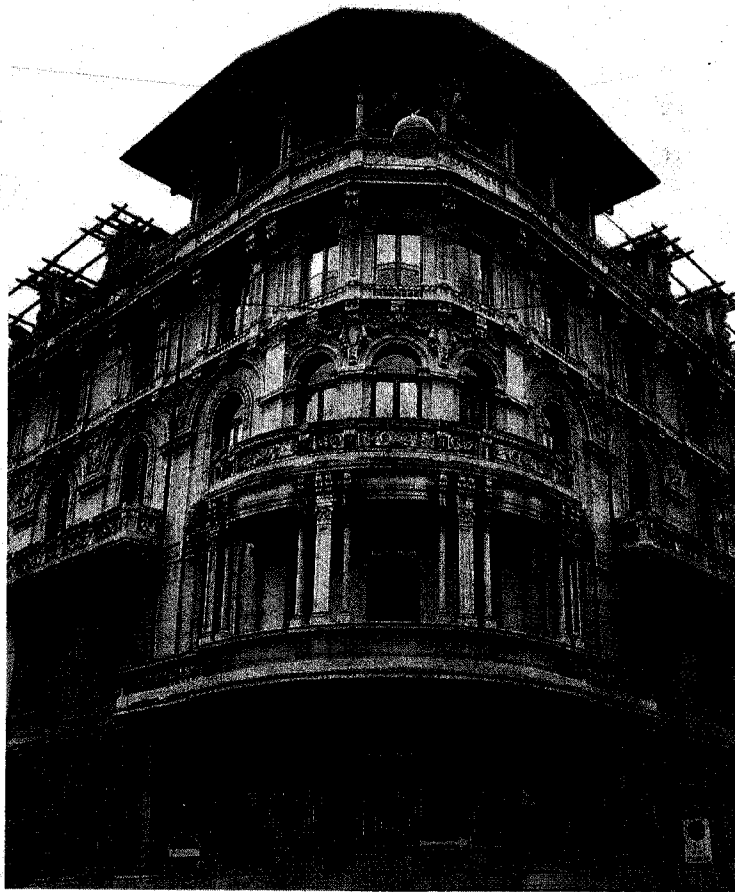
Difficili da nascondere. Il patrimonio è più tracciabile dei redditi: immobili (nella foto un'abitazione di pregio a Milano), complessi aziendali e partecipazioni societarie non sono occultabili e un'imposta sul patrimonio potrebbe contare su una base imponibile ampia
